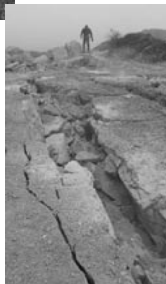
Photo 2 : Sol fissuré, à quelques mètres du tir (Photo P. Dumoulin)
