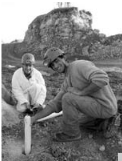
Photo 1 : Chargement d'une mine (Photo P. Dumoulin)
