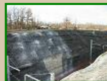
Confortement de béton projeté par grillage
