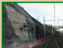
Confortement de béton projeté par grillage
