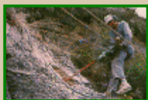
Forage au T18
