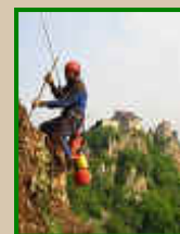
Purge en falaise et dévégétalisation
