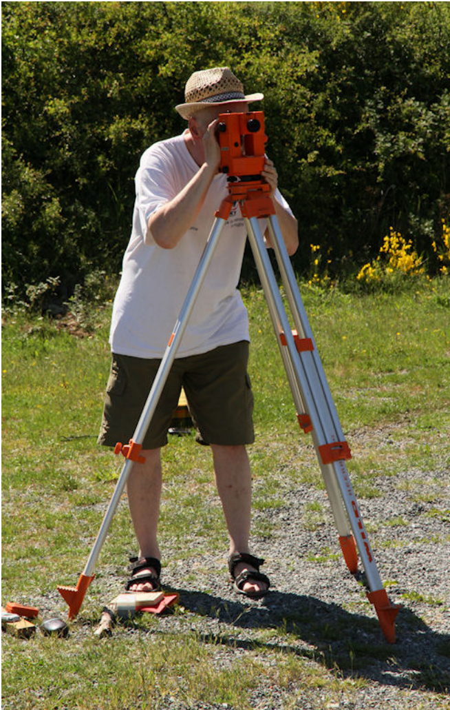
Figure 1 : Travaux au col de Thalys, François au théodolite
