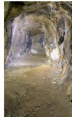
Exemple d'un levé Lidar texturé par iPhone d'une galerie de mine d'une centaine de mètres de long (vue en plan et d'une partie de l'intérieur). F. Guillot et D. Langlois
