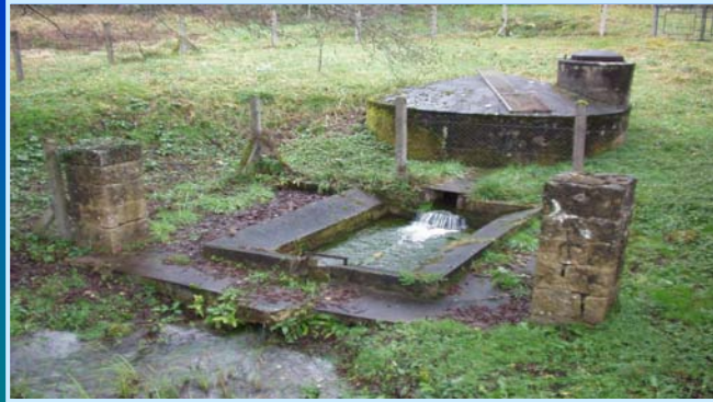
Captage A.E.P. de la source de Nadaillac Commune de Payrignac - Lot
